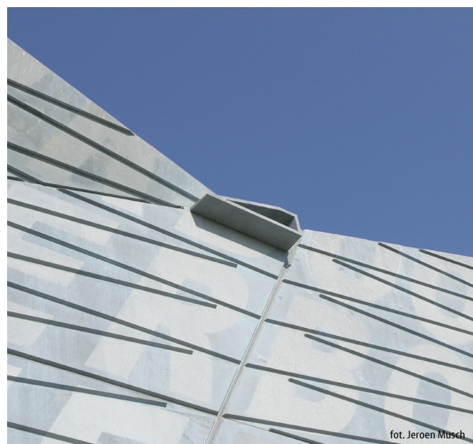
Ryc. 231. Przepompownia ścieków Amsterdam Wschód. Detal stylu płaszczyzn tworzących elewację południową
