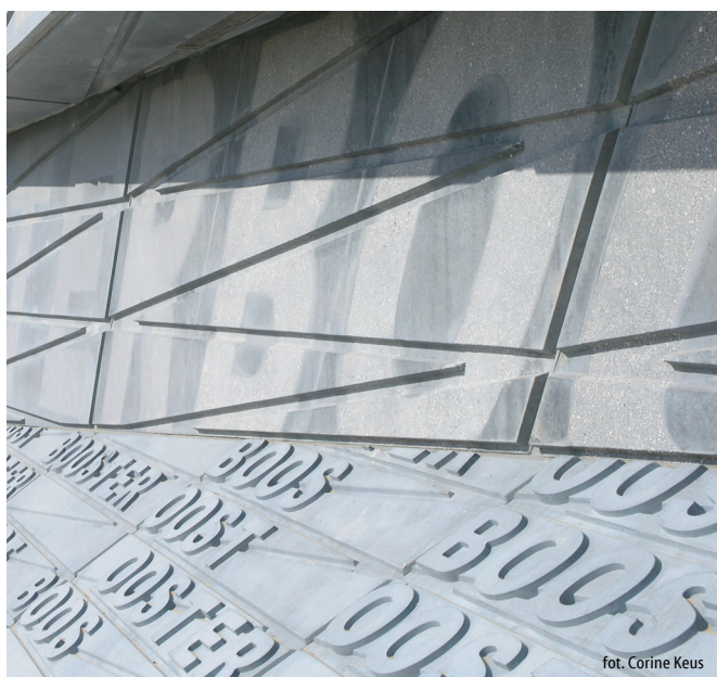
Ryc. 229. Przepompownia ścieków Amsterdam Wschód. Styk elewacji z cokołem. Słowo BOOSTER jako relief (na partii cokołu) i ornament (na płytach elewacji)
