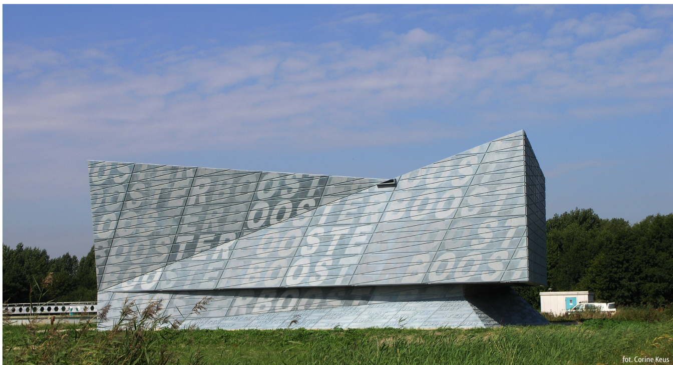
Ryc. 225. Przepompownia ścieków Amsterdam Wschód. Widok od strony południowej
