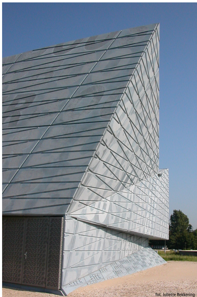
Ryc. 226. Przepompownia ścieków Amsterdam Wschód. Widok od strony południowo-zachodniej
